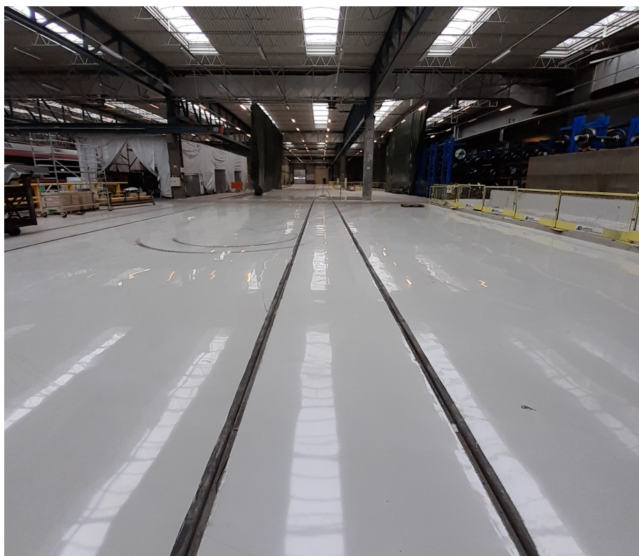
Grorud: Her kommer den nye lakkhallen, planlagt ferdig høsten 21.
