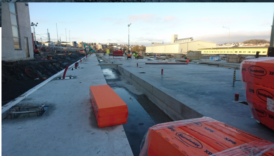
Bildene viser startfasen av bygginga av det nye verkstedet på Kvaleberg i Stavanger. Under planleggingen er det ikke tatt godt nok hensyn til alle materielltyper, noe som kan resultere i problemer med vedlikehold av type 73.
